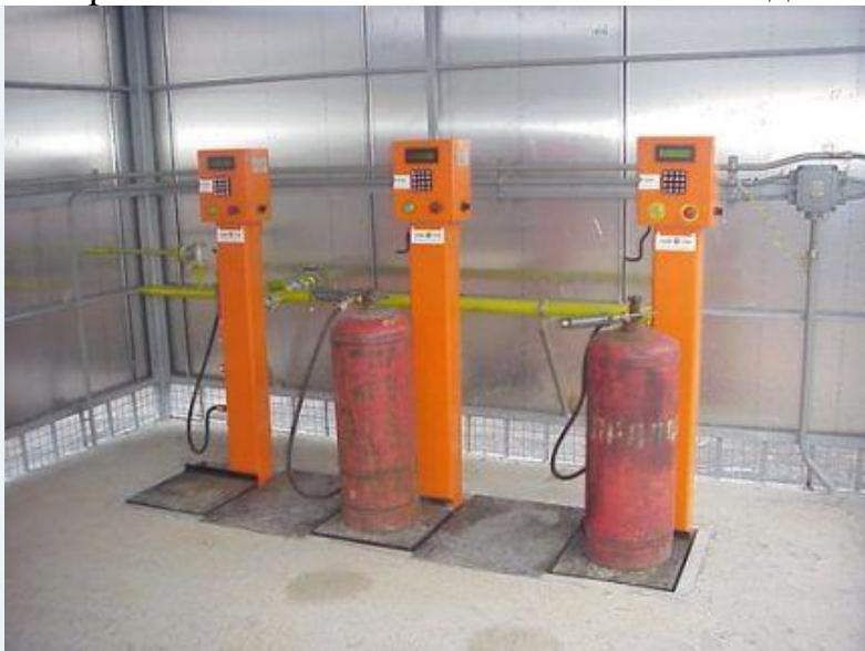
Заправка газового баллона должна контролироваться с помощью электронных весов
