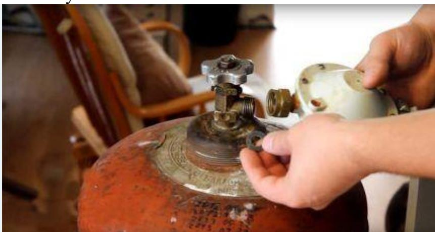
При соединении резьбовых соединений нужно предварительно намотать 3-4 слоя газовой фум-ленты и произвести затяжку гайки с достаточным усилием
