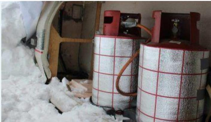
Термочехлы предохраняют газовые баллоны от критического снижения температуры
